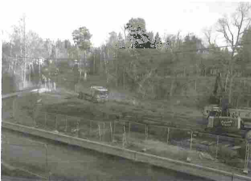
Bilden visar utbyggnad av vatten, avlopp och vägar i Norra Boo.
