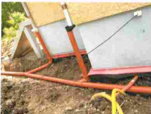
Bild 4. Dagvattenledningarna från stuprören till kassetten i gräsmattan
