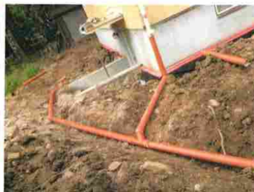
Bild 4. Dagvattenledningarna från stuprören till kassetten i gräsmattan
