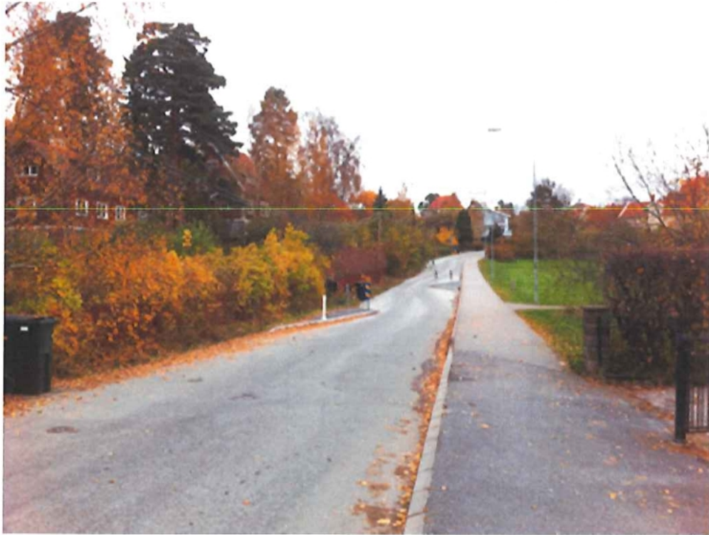
Figur 2 Igelbodavägen där schikaner har byggts för att begränsa hastigheten på sträckan.
