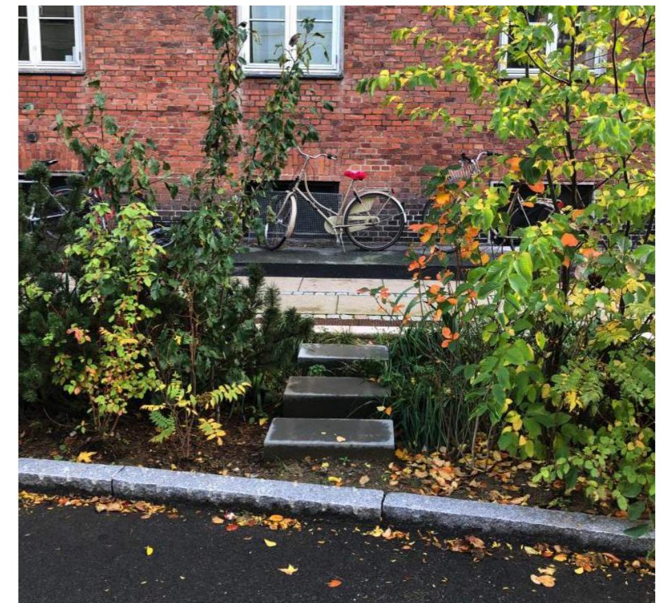
Nedsänkt plantering för dagvatten mellan gata och trottoar.
