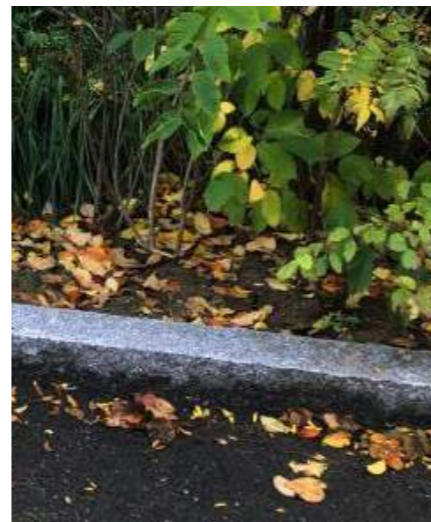
Kantstöd av råkilad granit.
