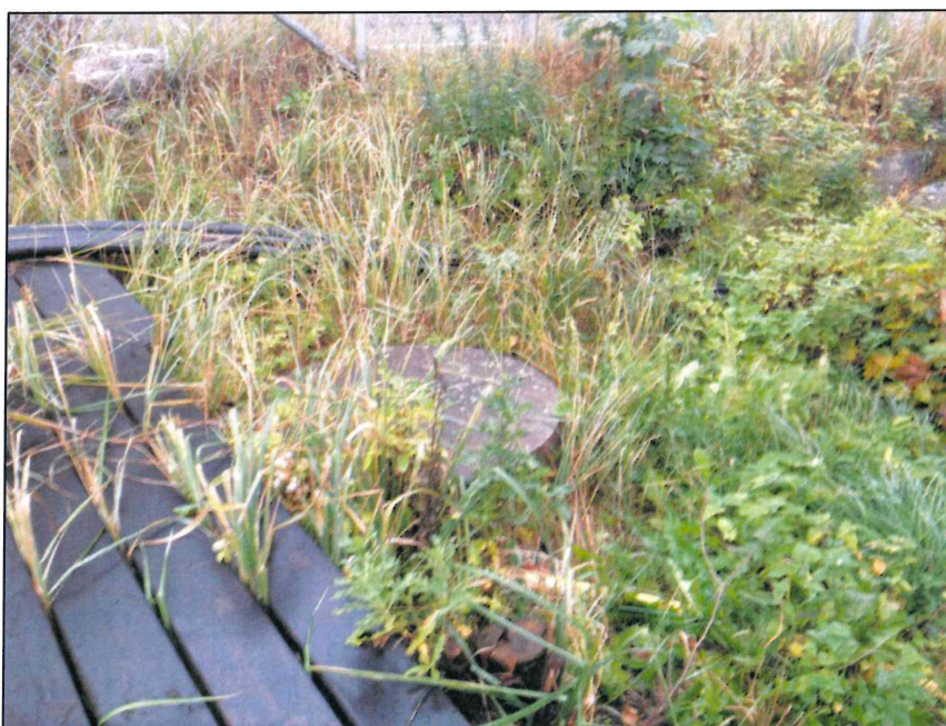
Figur 3. Bilden till vänster visar brunnen på kulverten för bäcken
