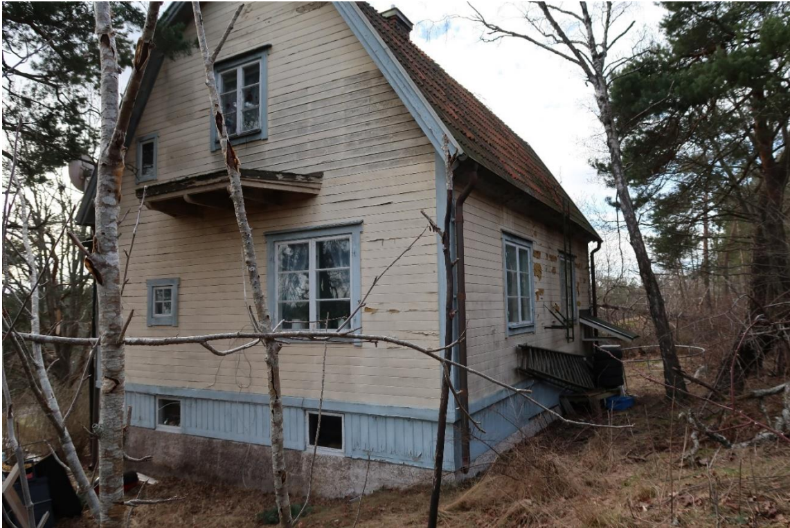
Norra och östra fasaden sedda från tomtens nordöstra hörn. Balkongen i övervåningen har tagits ur bruk och väggen byggts om.
