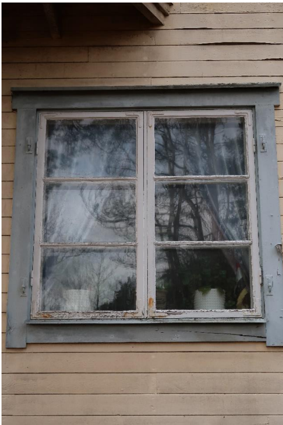
Ett av originalfönstren.
