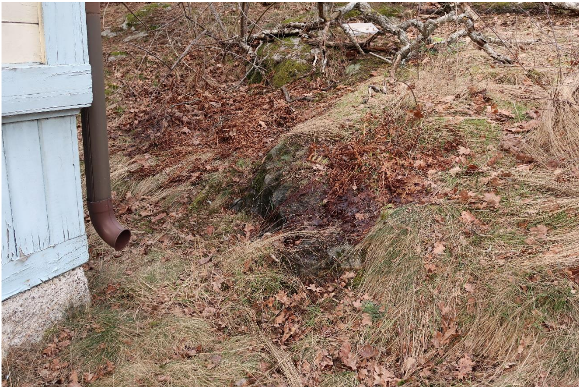
Hög marknivå vid byggnadens nordöstra hörn.
