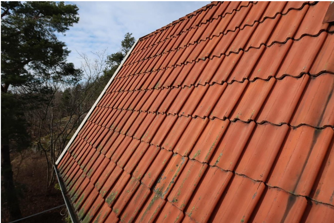
Taket med tvåkupigt taktegel.
