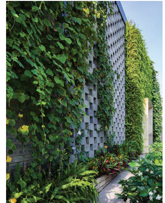
Växtlighet på fasad med struktur
