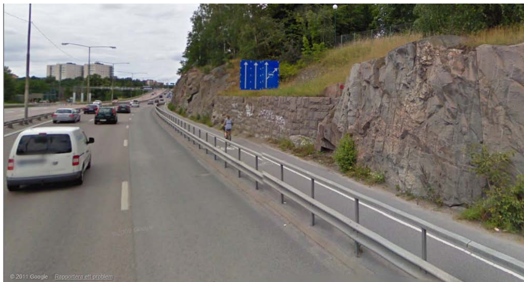
Figur 9 Exempel på cykelbana utmed stor trafikled, Roslagsvägen E 18
