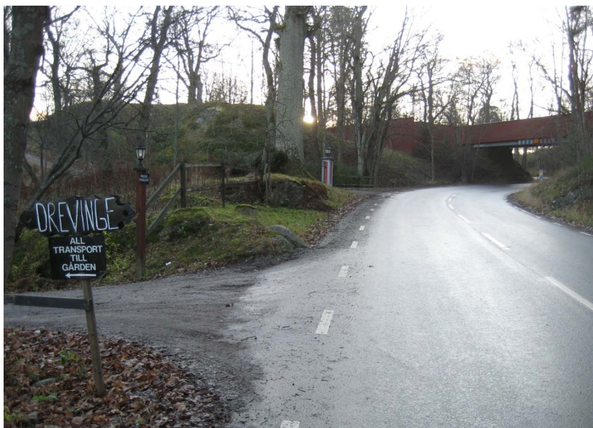
Figur 6 In-/utfart, kurva med dålig sikt samt smal passage under Saltsjöbanan
