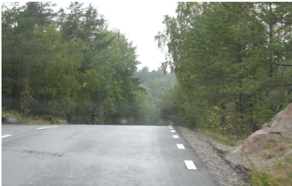
Figur 5 Krön med dålig sikt Saltsjöbadsvägen
