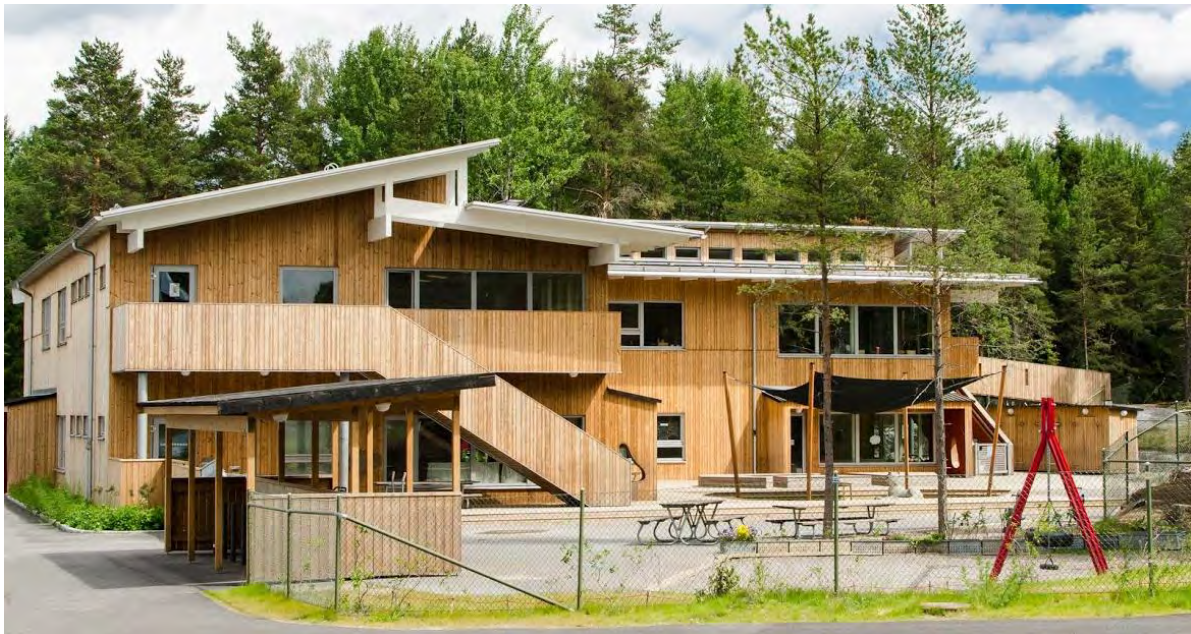
Källängsvägens passivhus förskola med solfångare på tak för extra energi vid behov
