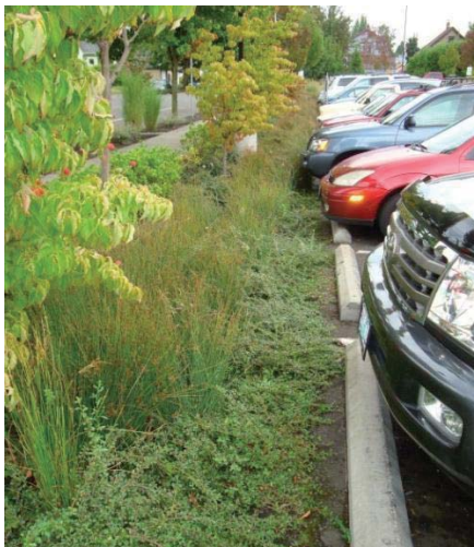
Figur 11. Exempel på utformning av svackdiken längs gata och parkeringsyta, med olika typer av kantsten och utan kantsten. Bilden nedan th är tagen på Sockenvägen i Stockholm, övriga är tagna i Portland, USA.
