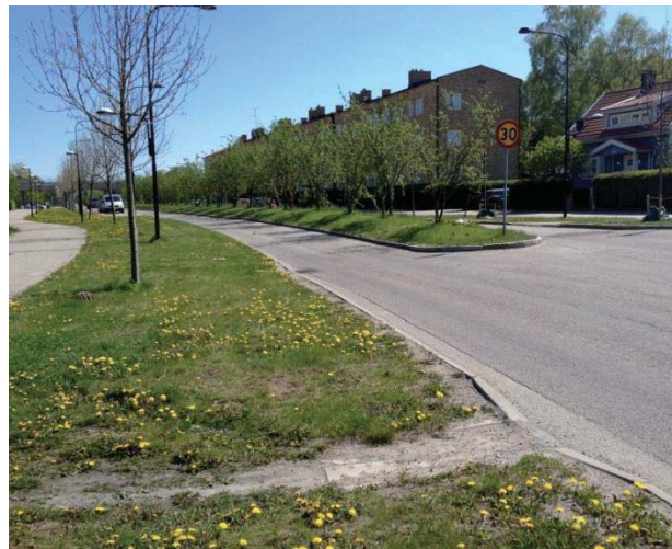
Figur 11. Exempel på utformning av svackdiken längs gata och parkeringsyta, med olika typer av kantsten och utan kantsten. Bilden nedan th är tagen på Sockenvägen i Stockholm, övriga är tagna i Portland, USA.
