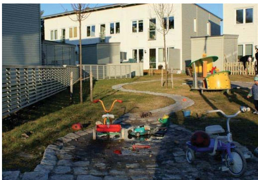
Figur 14. Exempel på rännदार och ytlig avledning i Oslo, Stockholm och Malmö.
