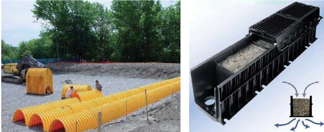
Figur 20 Exempel på lösningen StormTech (th) och D-Rainclean. 3
