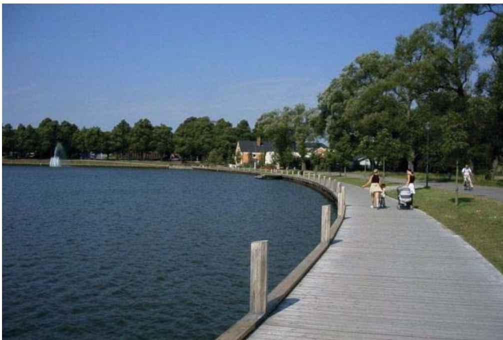
Figur 22. Exempel på utformning av sjöförlagda dagvattenanläggningar med bryggor. I nedre bilden visas en spontad anläggning under promenadstråk i Stockholm och Växjö.
