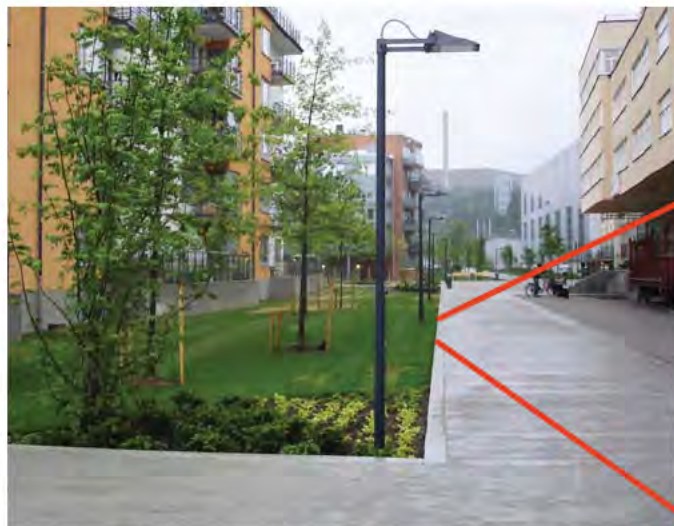
Exempel på promenad belagd med ofasad betongsten, kv Kölnan, Hammarby sjöstad.
