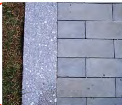
Exempel på promenad belagd med ofasad betongsten, kv Kölnan, Hammarby sjöstad.
