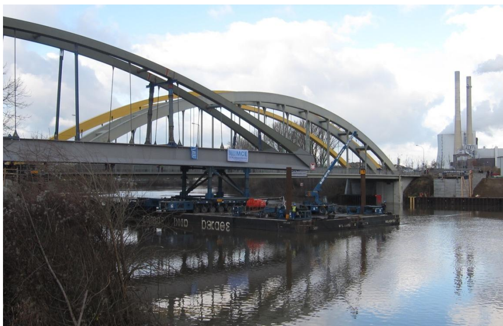
Figur 2. Liknande ponton med tillfälligt brostöd vid lansering.
