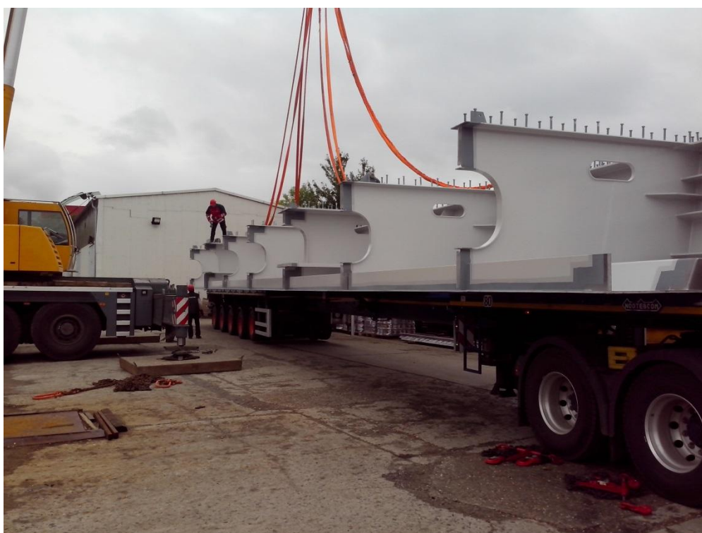
Figur 5. Bild vid lastning av brodelar på fabrik, 2014-09-01.
