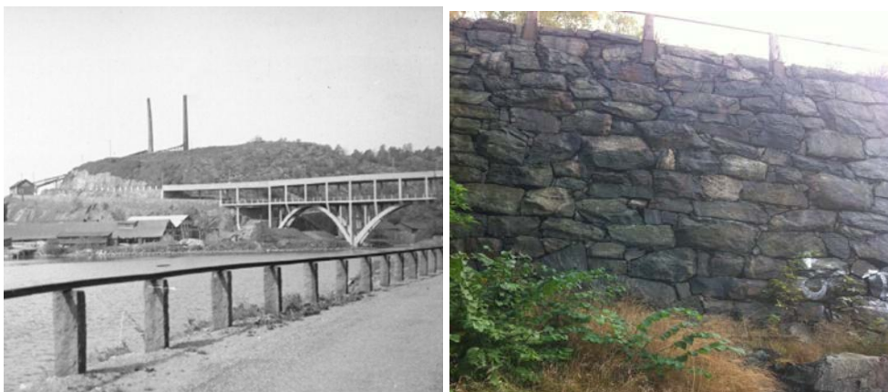
Dubbelbron invigdes 1932. Den övre delen som trafikförsörjde bostadsområdet revs dock 1985. Kvar finns ett kallmurat brofäste, beläget inom planområdet.
