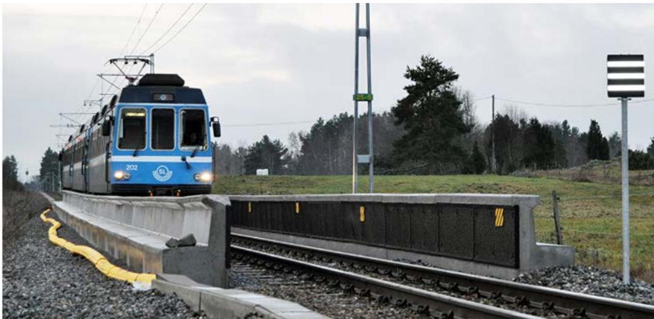
Exempel på låga bullerskärmar nära spår. Här på Roslagsbanan.
