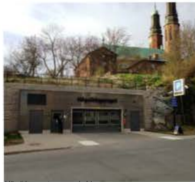
Högalidsgaraget - exempel på bergrumsgarage
