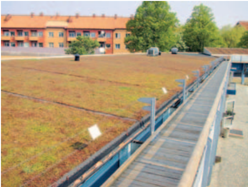
Bild 1. Grönt tak. En långsiktig hållbar dagvatten- hantering, 2004.
