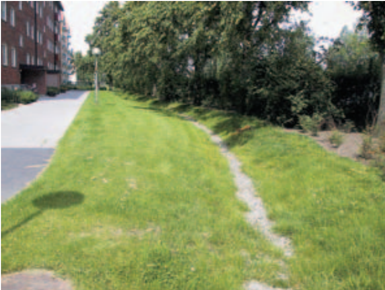
Bild 7. Stensatt svackdike på en skolgård. En långsiktigt hållbar dagvattenhantering, 2004.
