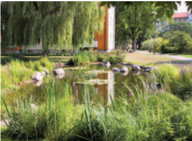
Bild 8. Lokal födröjnings- damm i ett bostads- område. En långsiktigt hållbar dagvattenhantering, 2004.
