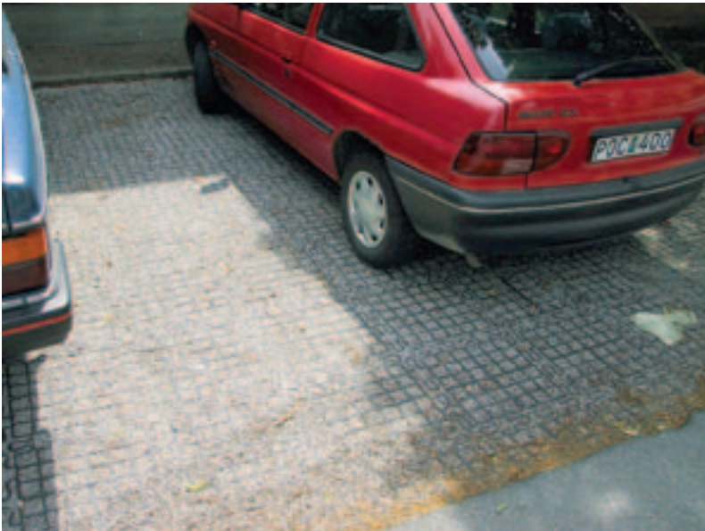
Bild 4. Parkeringsyta med singel som stabili- serats med rasternät av polyetenplast. En långsiktigt hållbar dagvattenhantering, 2004.
