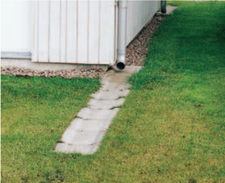
Bild 3. Detaljbild av stuprörsutkastare. En långsiktigt hållbar dagvattenhantering, 2004.
