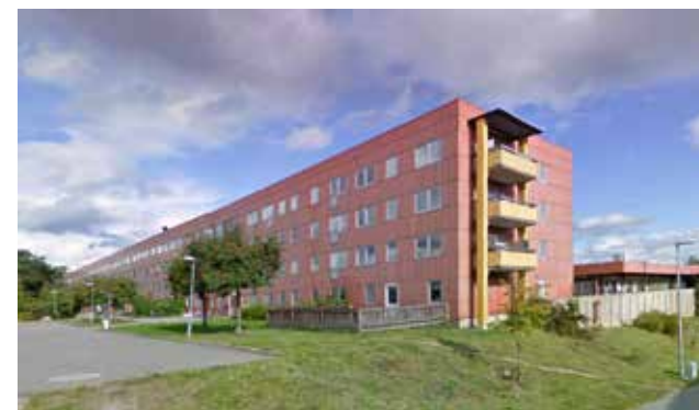
Röda längan inrymde tidigare personalbostäder för sjukhuset. Den 200 meter långa plåtklädda byggnaden är ett landmärke i centrum.
