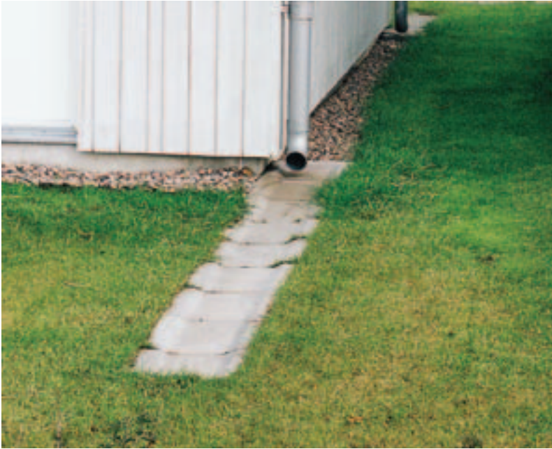
Bild 3. Detaljbild av stuprörsutkastare. En långsiktigt hållbar dagvattenhantering, 2004.
