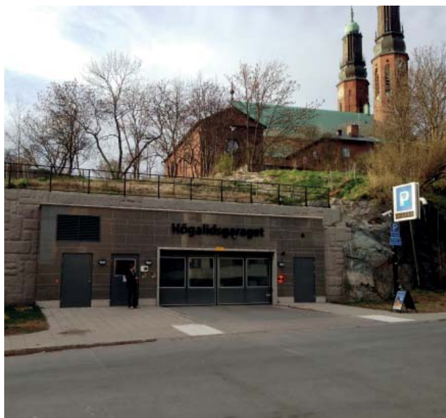
Högalidsgaraget - exempel på bergrumsgarage
