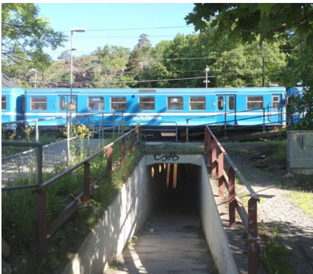
Tunnelundergången under Saltsjöbanan idag där förlängningen av Planiavägen planeras förläggas.
