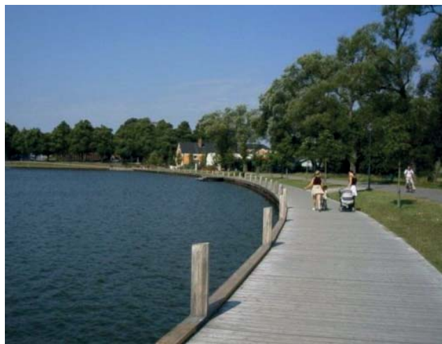
Exempel på strandpromenad med dagvattenrening i Växjö. Sedimenteringen sker under bryggan genom att orenat vatten skiljs från renat vatten med hjälp av en avskärmande duk under vattenytan (bildkälla: Sweco).
