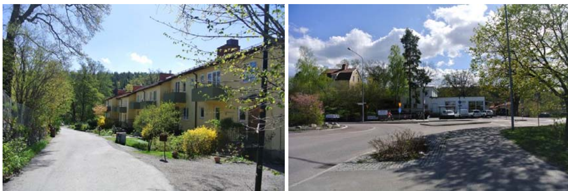
Fotot till vänster: Radhusområdet väster om fastigheten (vy mot söder). Fotot till höger: Den befintliga byggnadens exponerade läge.
