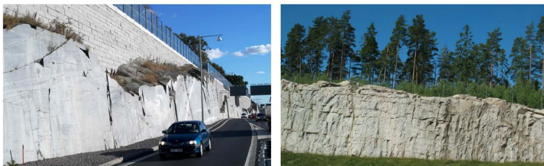
Fig. 26 Medveten släntning eftersträvas i området. I den vänstra bilden syns ett exempel på vajersågning och i den högra ett exempel på sprängning med tätsöm. (Källa: Trafikverket)
