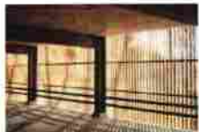
Parking Garage / Birk Heilmeyer und Frenzel Architekten
