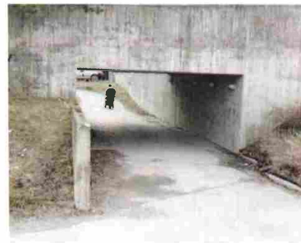
Gång- och cykeltunnel vid panncentralen
