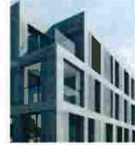
Synlig betongstomme som grafiskt mönster Zentrumsüberbauung Rosengarten / Max Dudler
