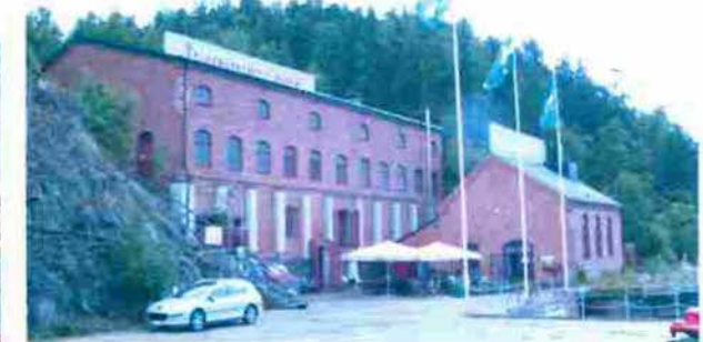
Befintliga tegelhus på kajen
