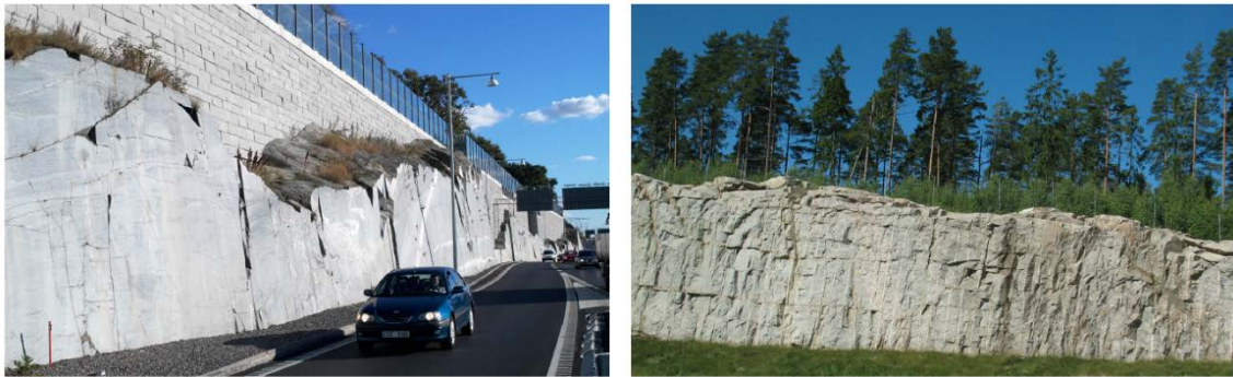
Fig. 28 Medveten släntning eftersträvas i området. I den vänstra bilden syns ett exempel på vajersågning och i den högra ett exempel på sprängning med tätsöm. (Källa: Trafikverket)
