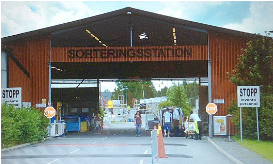
Fig 20. Kretsloppsparken Alelyckan, Göteborg, mottagningshallen Referens: www.mittsundbyberg.se
