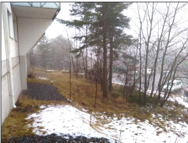
Figur 4. Utkastare från fastighet längs Diligensvägen. Parkeringsytan skymtar mellan träden.
