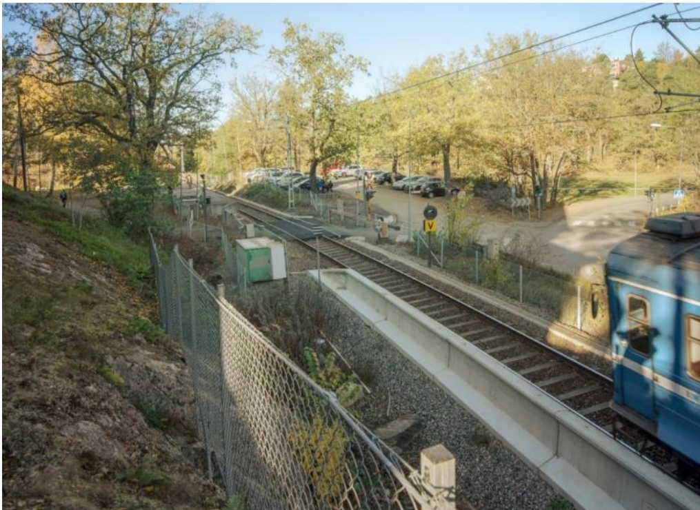
Till höger ses Byvägen/Skyttevägen och infarten till parkeringen. Över spåret ses den signalreglerade plankorsningen. Foto av Sweco Architects AB.
