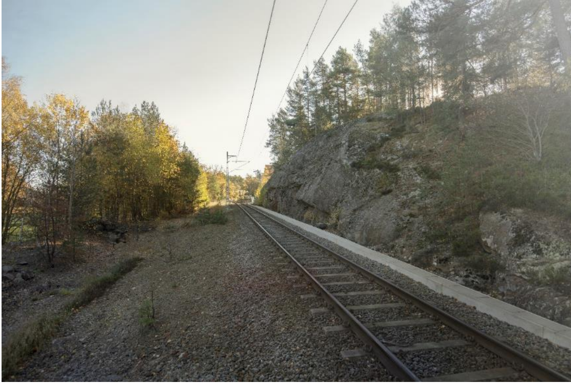
Illustration A1: Dagens enkelspår, vy från väster. Till vänster ses befintlig slänt av krossmaterial. Till höger ses nuvarande bergskärning. Foto av Sweco Architects AB.
