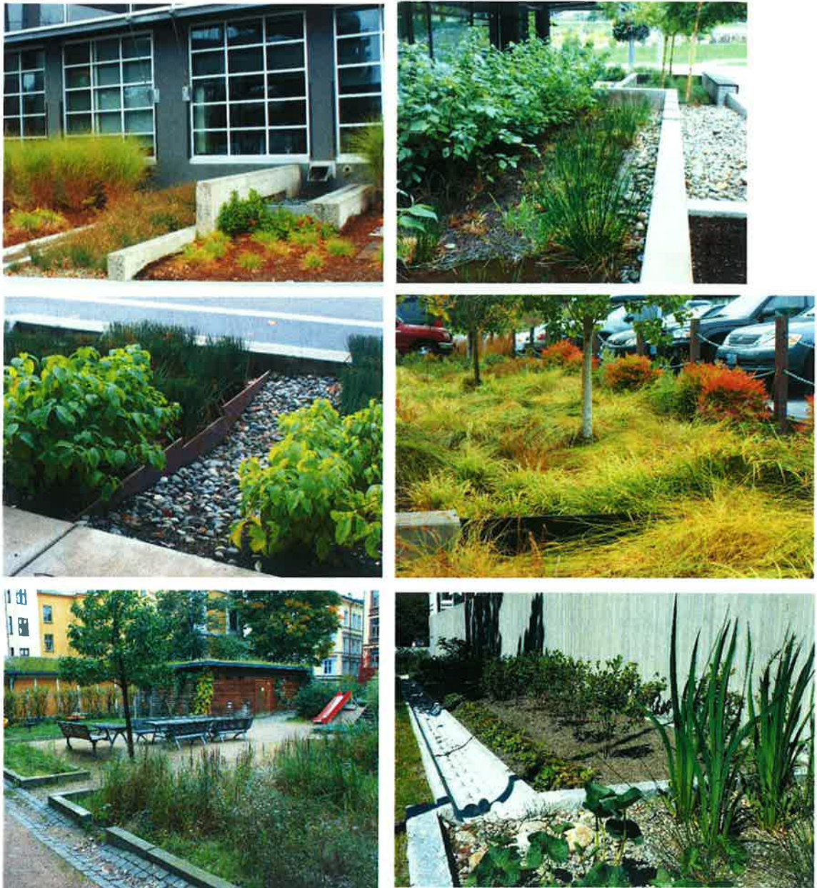
Figur 6. Bilderna visar exempel på seriekopplade regnbäddar på kvartersmark samt exempel på överfall och dämmen. Rännor kan avleda dagvattnet till regnbäddar men även fungera som bräddning i ett seriekopplat system. Exempelen kommer från Portland, Oslo och Stockholm.
