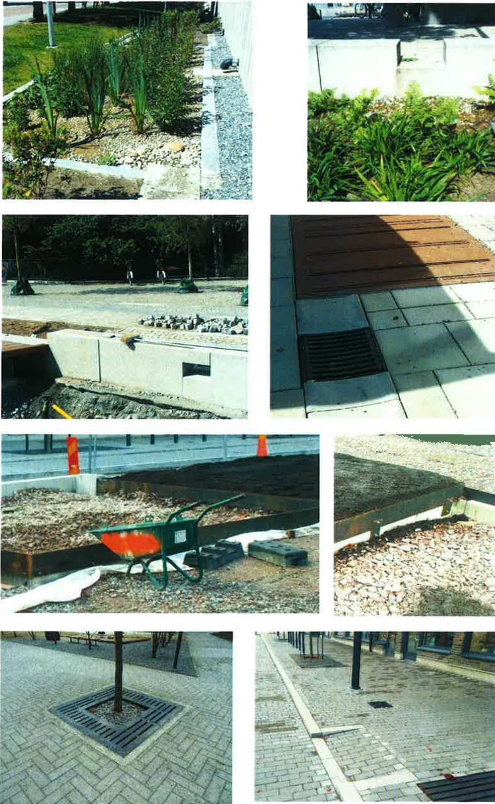
Figur 11. Exempel på utformning av skelettjordar, regnbäddar och olika typer av inlopp, Sverige.
