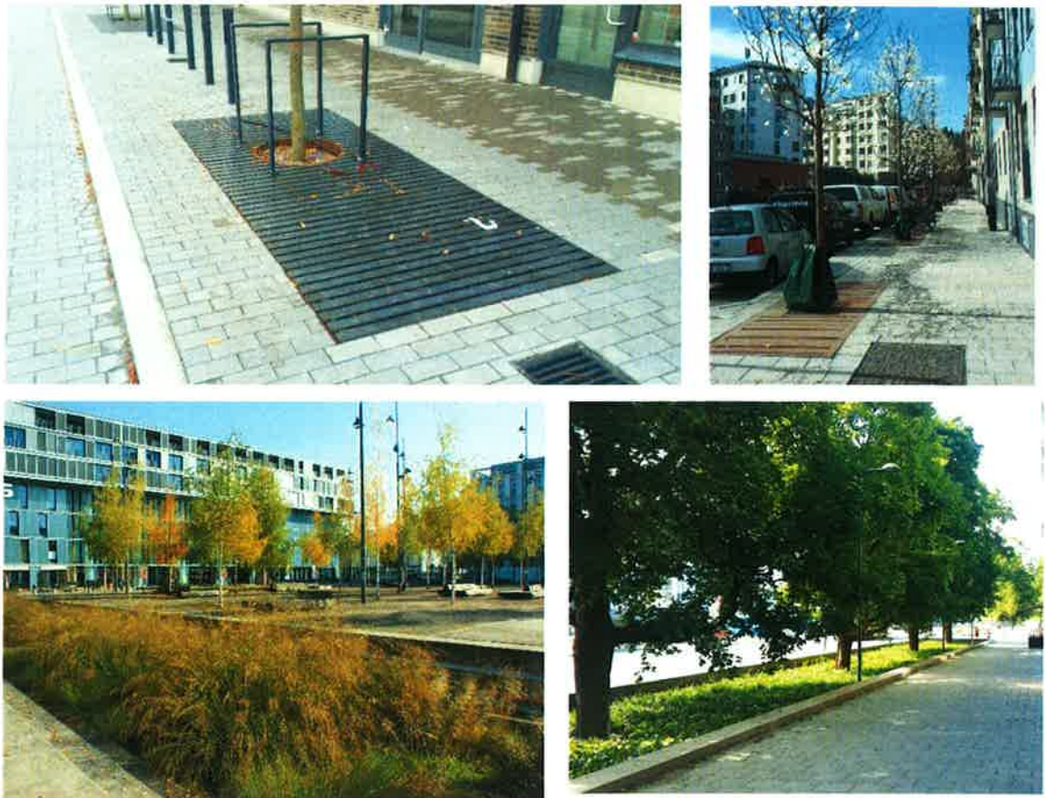
Figur 7 Exempel på öppen och täckt växtbädd i gaturummet, Norra Djurgårdsstaden.
