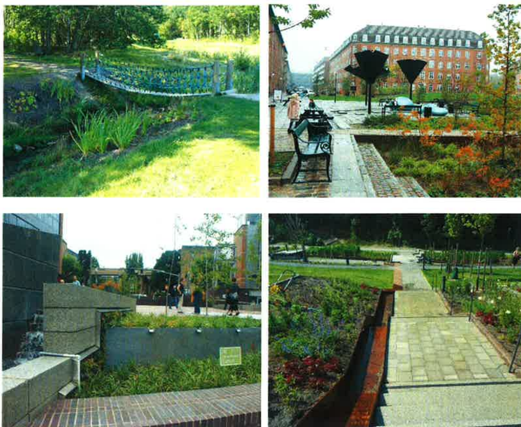
Figur 12. Exempel på dagvattenhantering i nedsänkta växtbäddar och avrinningsstråk på allmän platsmark.
