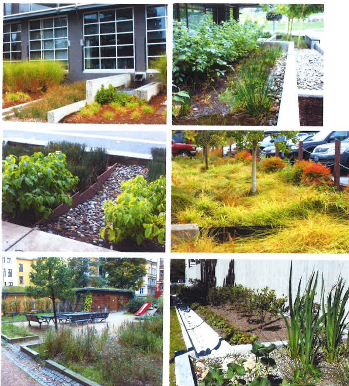
Figur 6. Bilderna visar exempel på seriekopplade regnbäddar på kvartersmark samt exempel på överfall och dämmen. Rännor kan avleda dagvattnet till regnbäddar men även fungera som bräddning i ett seriekopplat system. Exempler kommer från Portland, Oslo och Stockholm.
