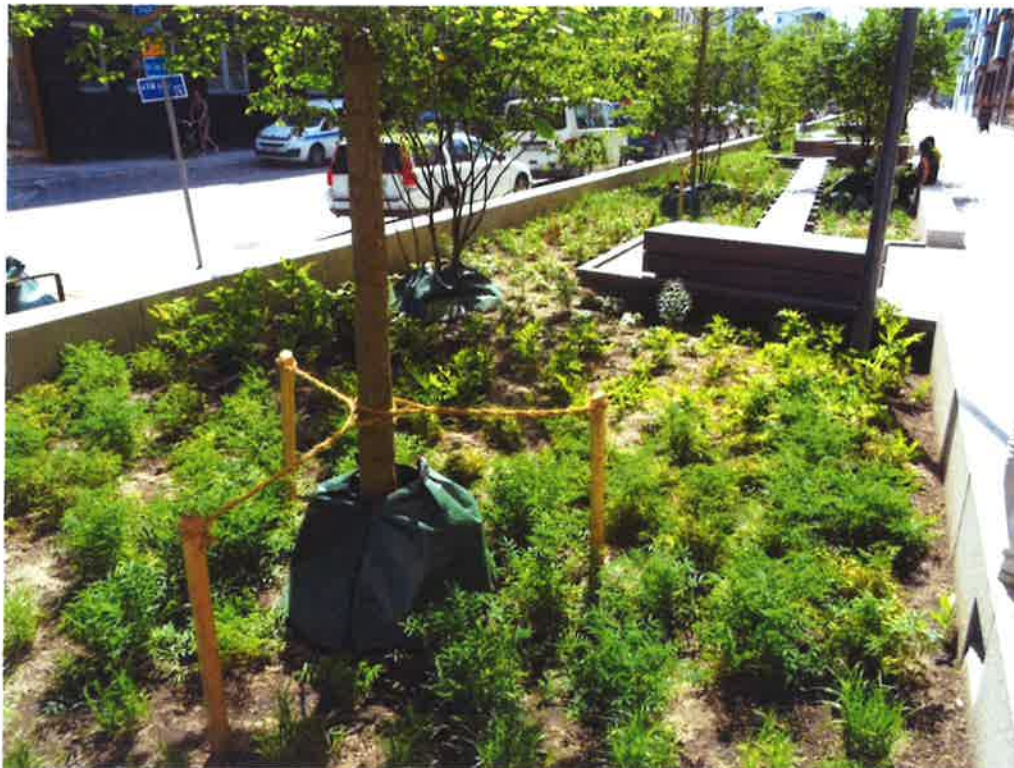
Figur 9. Öppna regnbäddar. Fungerar på liknande sätt, som en täckt regnbädd. En öppen regnbädd kan planteras med perenner, buskar och träd istället för markgaller. Bilden i exemplet ovan är tagen i Norra Djurgårdsstaden.
