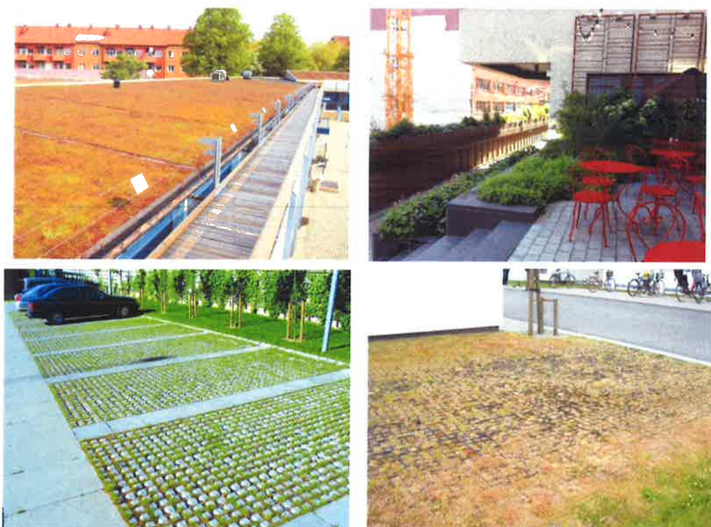
Figur 4. Nedre bilderna visar exempel på genomsläppliga beläggningar för parkeringsplatser och den övre bilden visar en bit av ett grönt tak i Stockholm som även används som en takträdgård.
