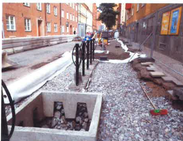
Figur 9. Exempel på etablering av skelettjord i befintlig miljö i Stockholm. Foto: Björn Embrén, Trafikkontoret Stockholm.
