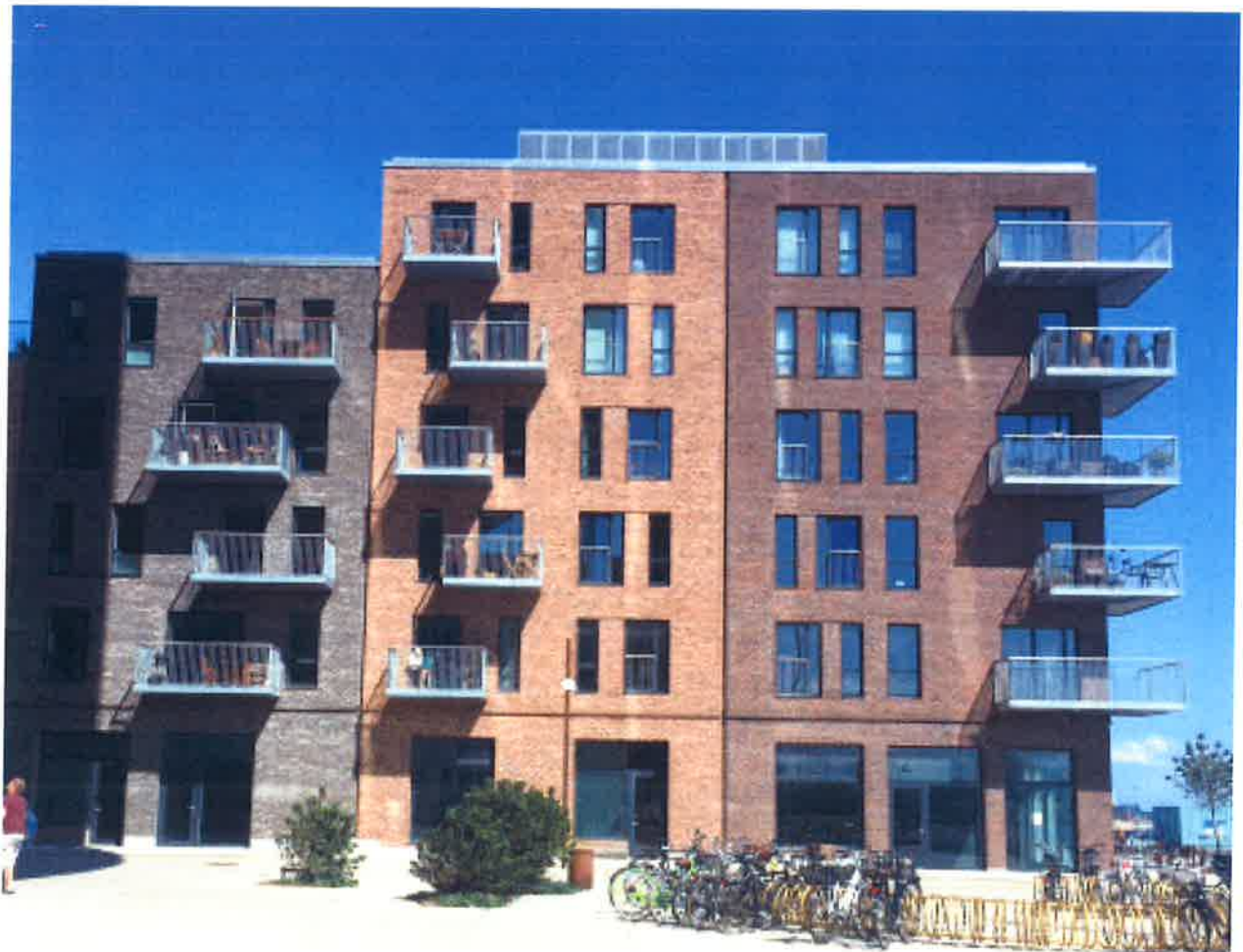
Referensbild: skarvar som medveten gestaltning samt balkonger.
