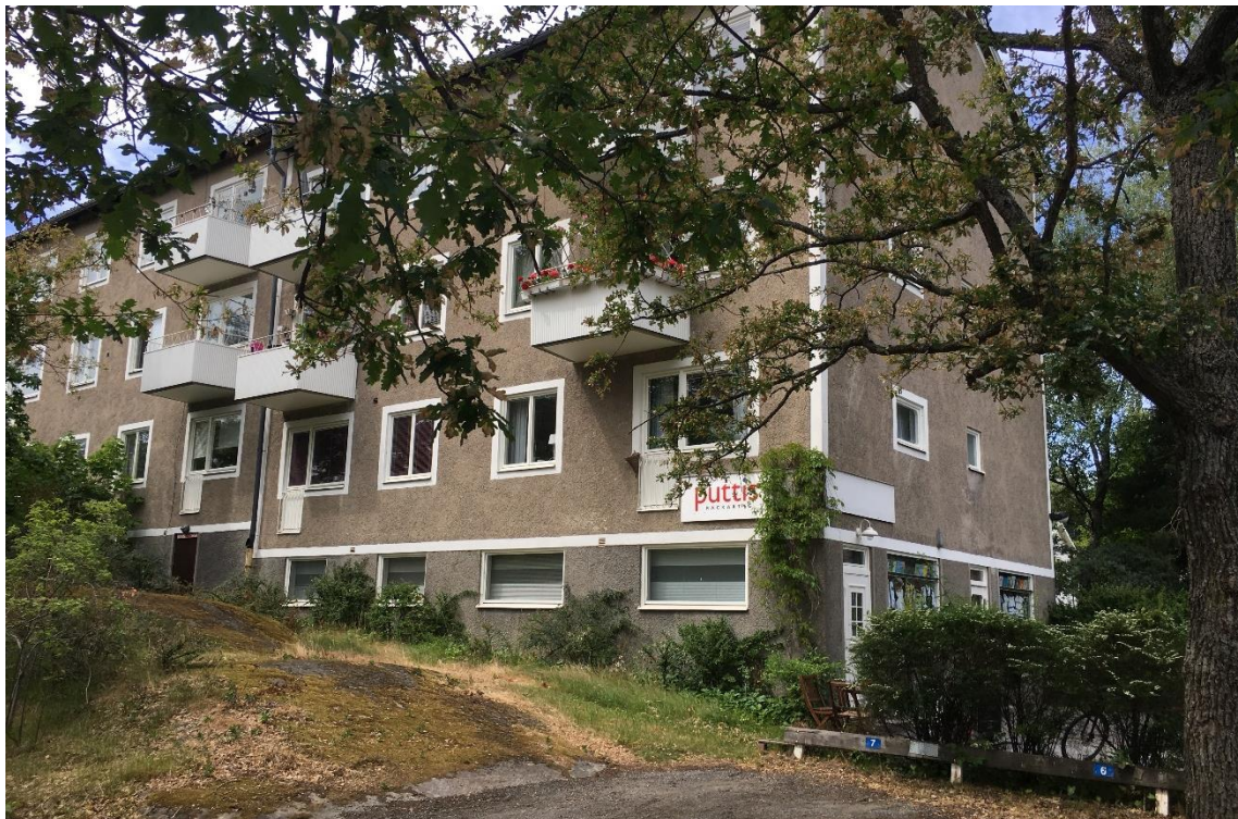
Figur 5. Flerbostadshuset på fastigheten Björknäs 1:239 byggt 1949. Notera fasaddetaljerna i vit slätputs. Foto: Viktor Wallström
