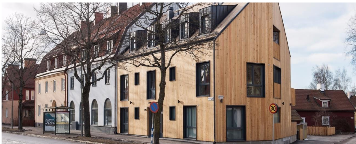
Figur 31. Flerbostadshus i trä på Gamla Tyresövägen. Byggherre Titania. Arkitekt & foto: Arkitema Architects
