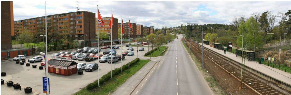
Planområdet väster om gångbron - befintlig bebyggelse, parkeringsytor, Fisksätravägen och Saltsjöbanan
