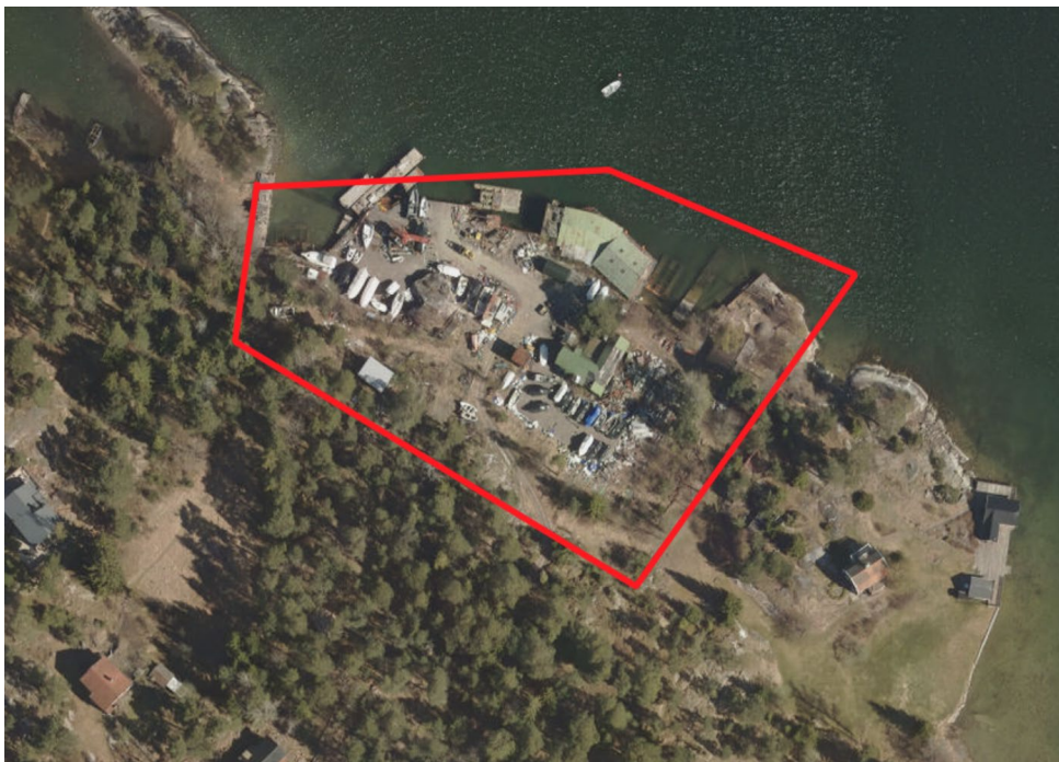
Snedvy och flygfoto över fastigheten.
