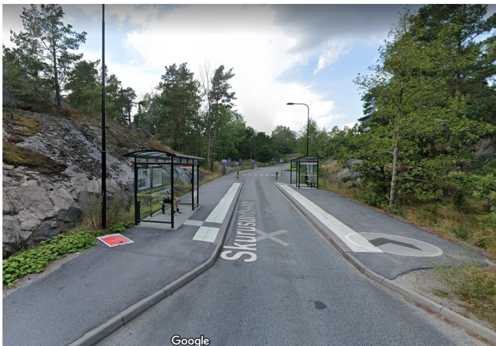
Skurusundsvägen efter ombyggnad (källa Google street)
