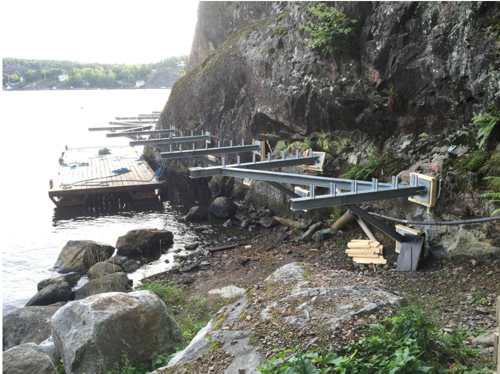
Ny gångbrygga till Kungsviken byggs
