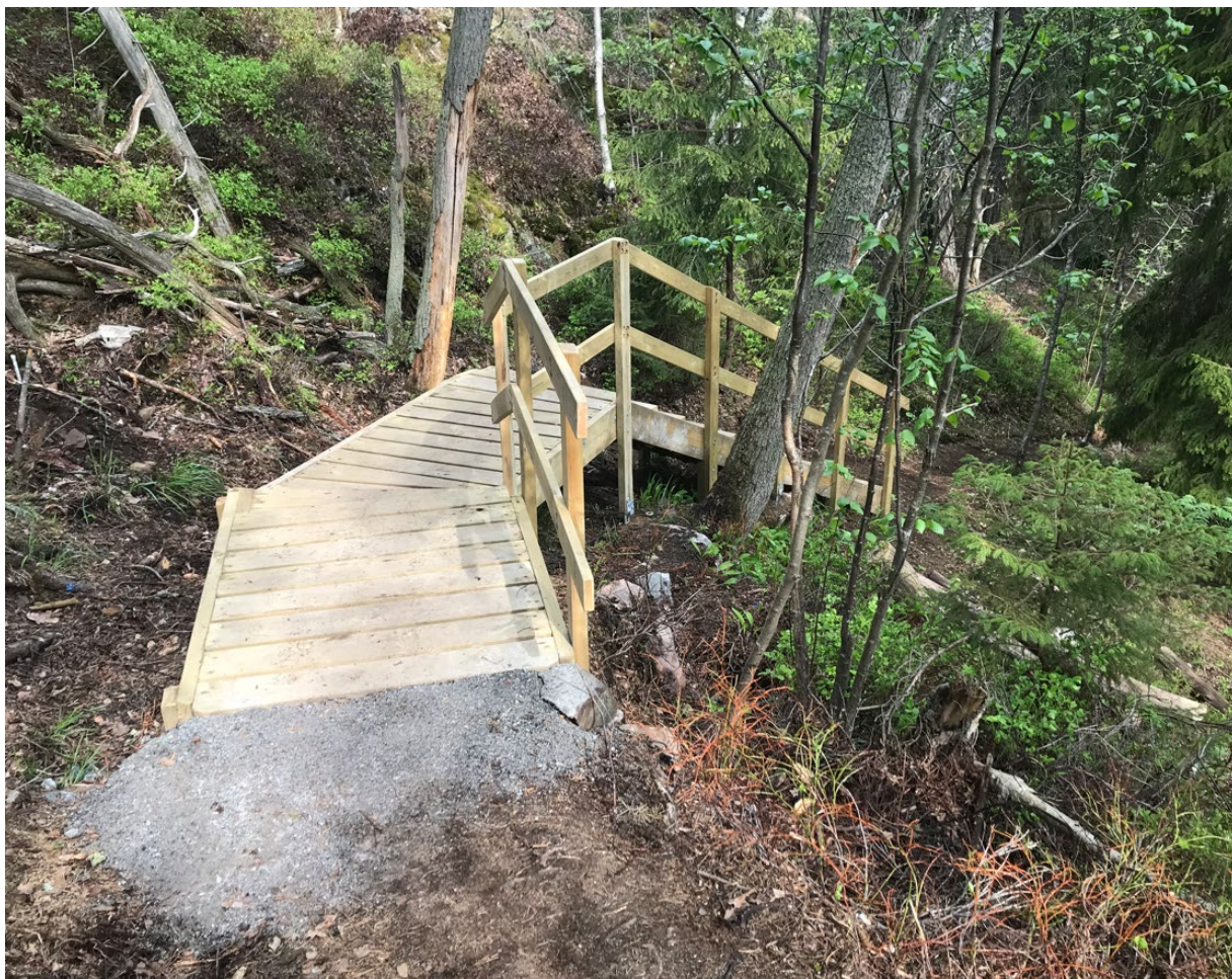
Naturstig rustas upp. Där det är svårt att ta sig fram anläggs trappor.
