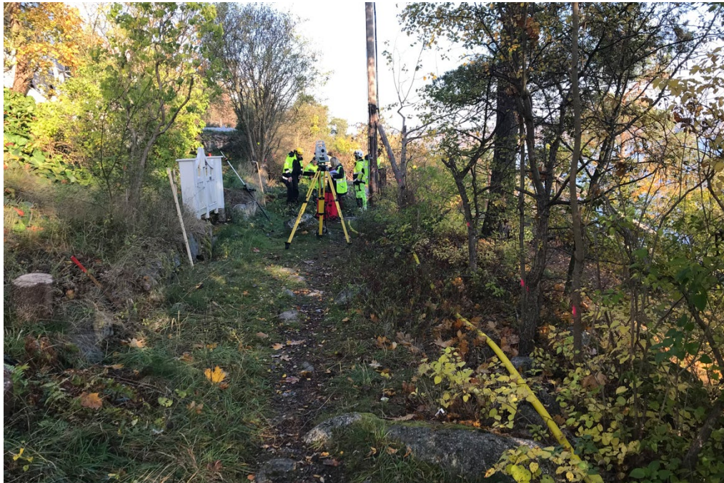
Ledungsstigen före utbyggnad
