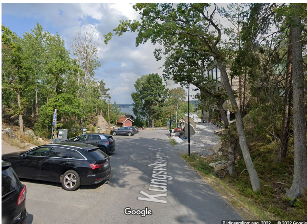
Kungsviksvägen efter ombyggnad (källa Google street)
