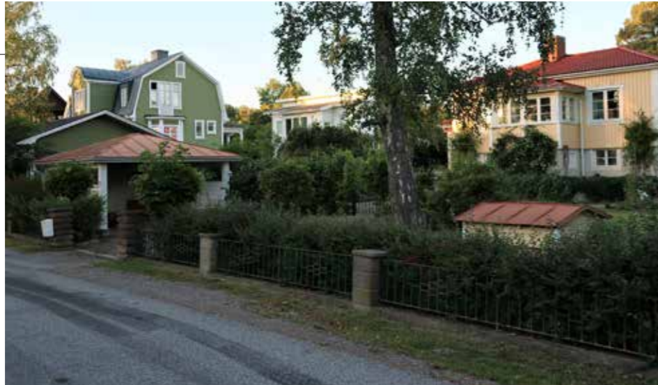
Figur 22. Äldre villabebyggelse vid Lövdalsvägen.
