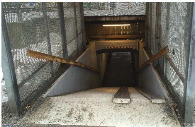
Dagens gångtunnel under Saltsjöbanan vid Nacka station.
