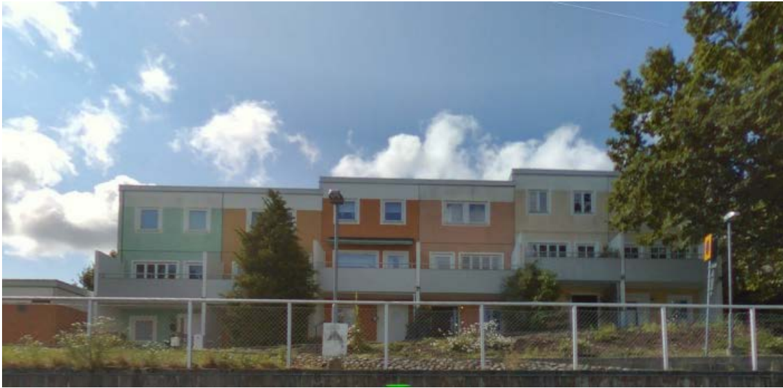
Figur 7. Befintlig radhusbebyggelse inom Östra Stensö Samfällighetsförening, direkt söder om planområdet.
