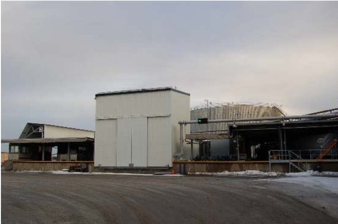
Fotografi på tapphuset så som det ser ut idag.
