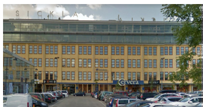
Befintlig fasad - Lufts-verkstad fasad mot Smedjegatan
