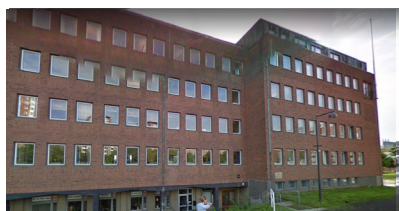
Befintlig fasad - Huvud kontor fasad mot Järnvägsgatan
