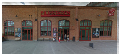
Befintlig fasad -Dieselverkstaden fasad mot Lufts-verkstad byggnad
