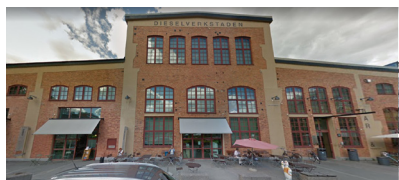
Befintlig fasad - Monteringshall fasad mot Marcusplatsen
