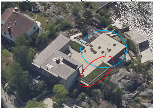
Flygbild från den 19 maj 2018. Entrégång inom den rödfärgade ringen. Tvåbostadshuset inom den blåfärgade ringen.
