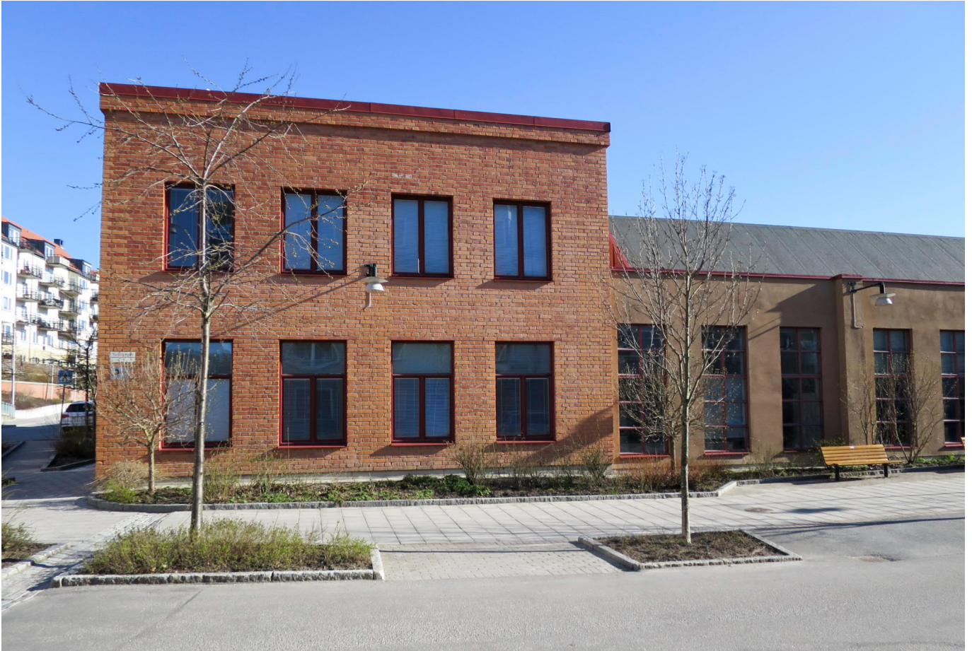
Fotografi av nuläget. Hus 93 sett från Turbinvägen. Tegelfasaderna i den västra delen av byggnaden (till vänster i bild) bevaras och påbyggs i förslaget. Den putsade östra delen (till höger i bild) rivs.
