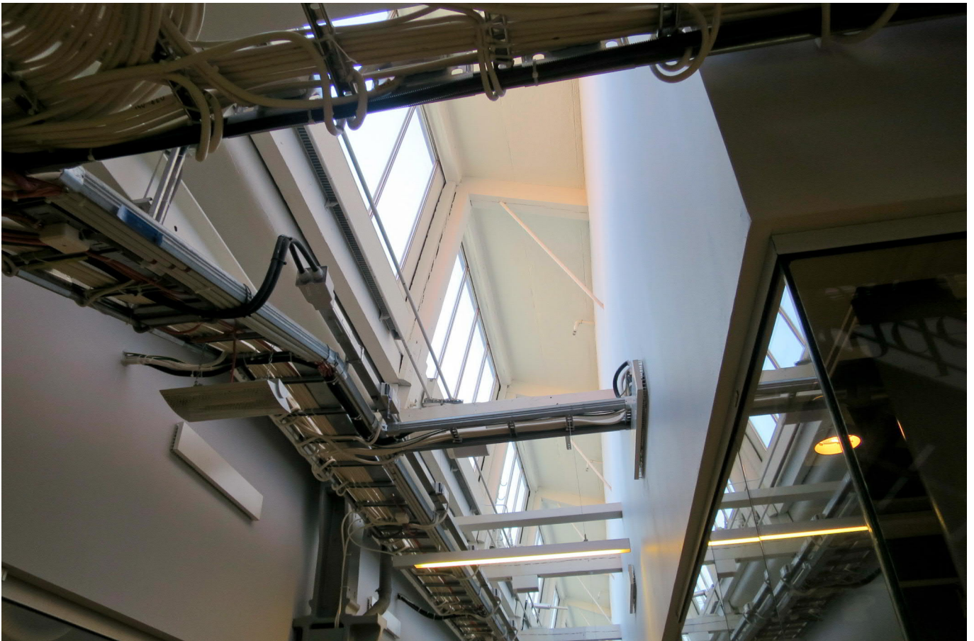
Fotografi av nuläget. Interiör i hus 51 (tidigare beteckning) som visar delar av sågtandstakets konstruktion.
