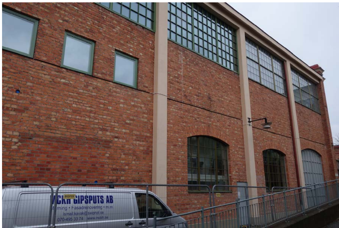
De två sista fönstren vid "Lavallhallen" är inte utbytta än, detta kommer att ske i maj/juni 2018. Den norra högdelen ingår inte i denna slutredovisning. Här syns tydligt hur den ursprungliga indelningen i sex fält inte längre finns i de ny tillverkade fönstren. Foto 2017 11 20
