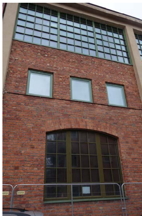
Del av östra fasaden efter ombyggnad. Befintliga fönstersnickerier är sentida och bevaras nedanför fönsterbandet. Foto 2017 11 20
