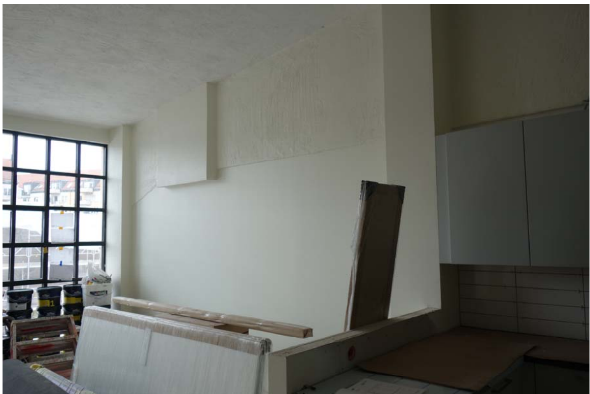
Tydlig redovisning av ny mellanvägg i förhållande till ursprunglig konstruktion. Efter ombyggnad. Foto 2017 11 20.
