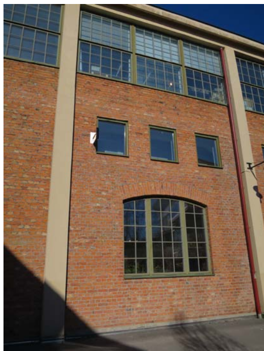
Del av östra fasaden före ombyggnad. Foto 2014
