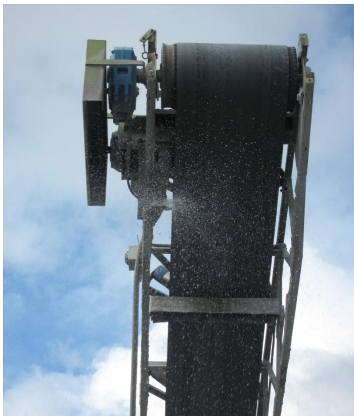
Figur 8-1 Transportband utrustad med s.k. dysa för vattenbegjutning när krossat bergmaterial lämnar transportband.
