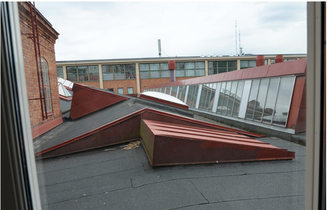
Fotografi av nuläget. Delar av sågtandstaket sett från ett fönster i Ritningskontorets övre våning.
