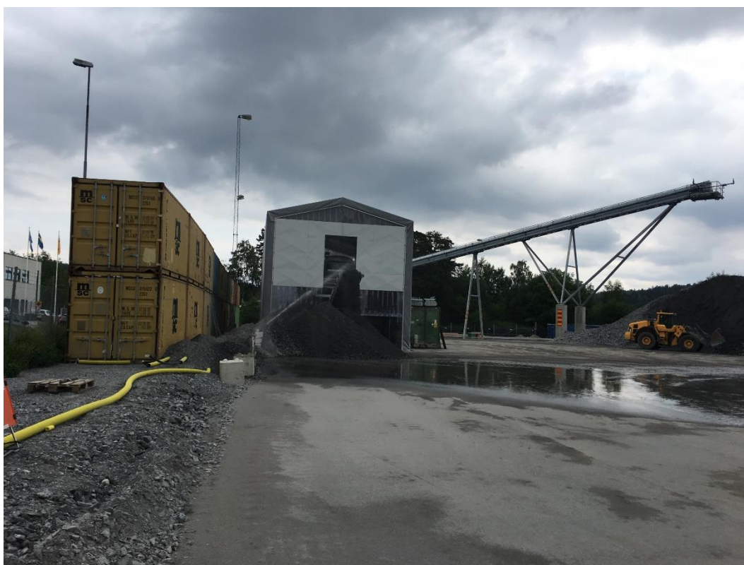
Figur 10. Bullerdämpande tält, kortsida, vid Skanskas anläggning i Slagsta.
