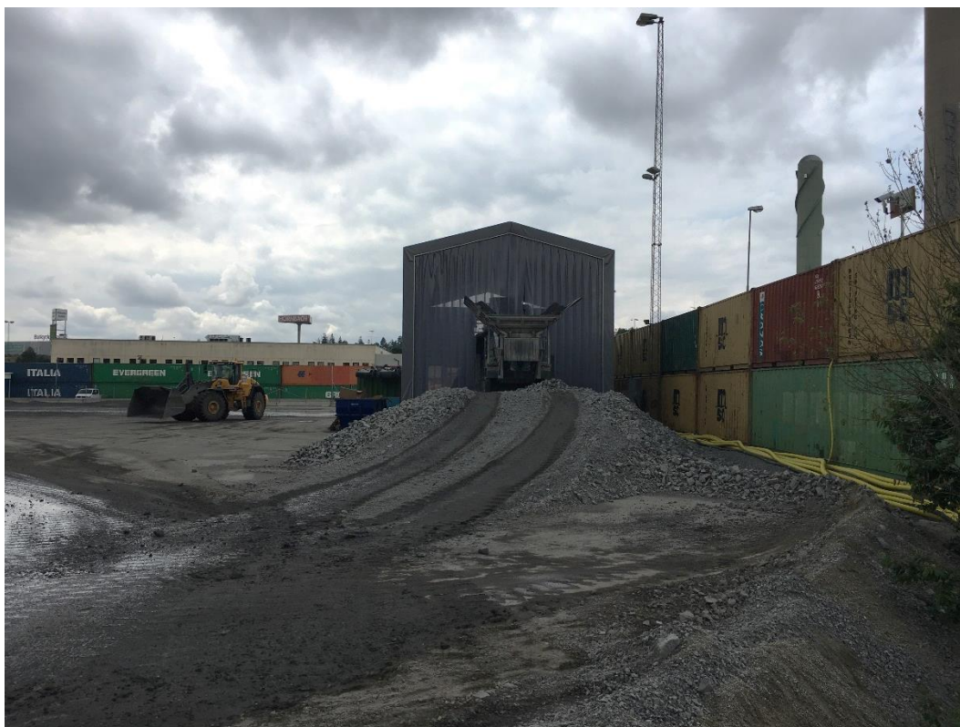
Figur 11. Bullerdämpande tält, kortsida, vid Skanskas anläggning i Slagsta.
