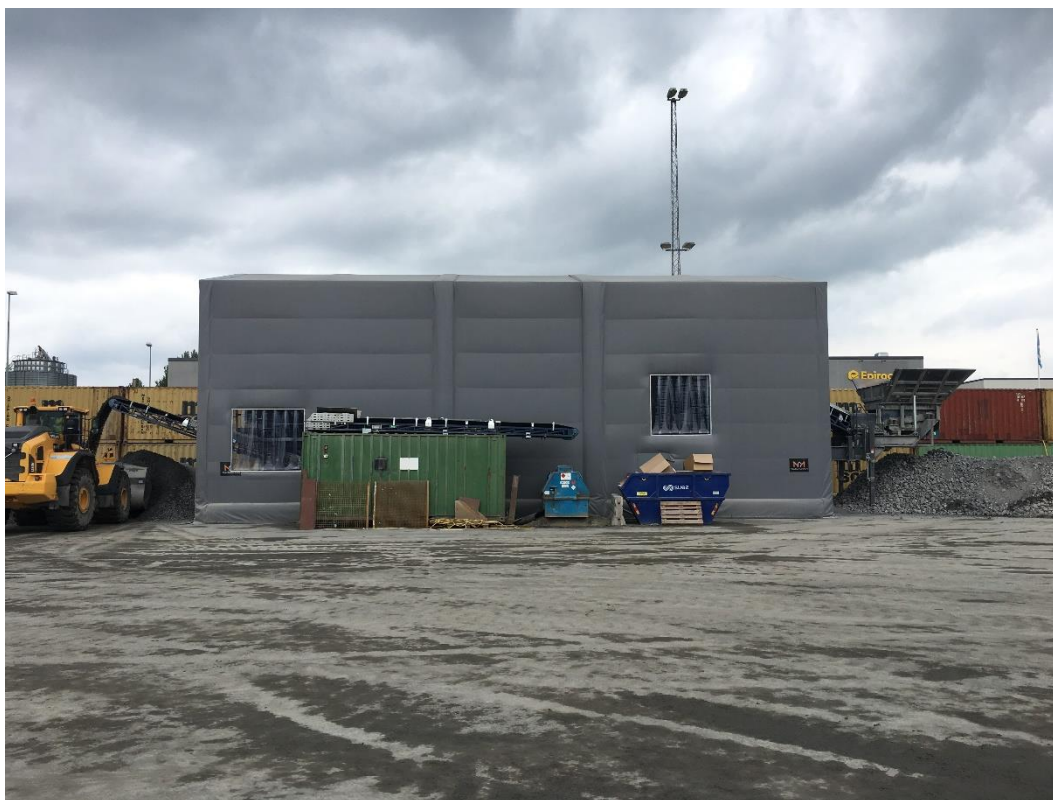
Figur 9. Bullerdämpande tält, långsida, vid Skanskas anläggning i Slagsta.
