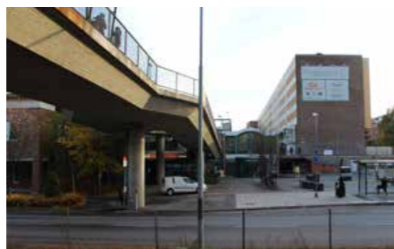
Gångbro över spåren och entré till centrumanläggning.
