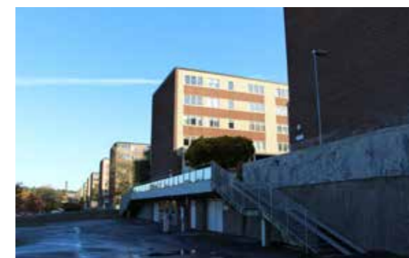
Entré till parkeringsgaragen med trappor till den övre nivån.
