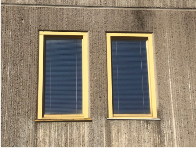
Accentfärger runt fönsterkarmar på befintlig bebyggelse.
