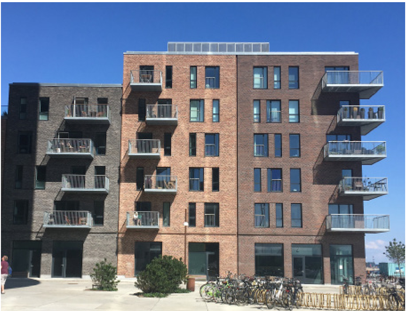
Referensbild: skarvar som medveten gestaltning samt balkonger.
