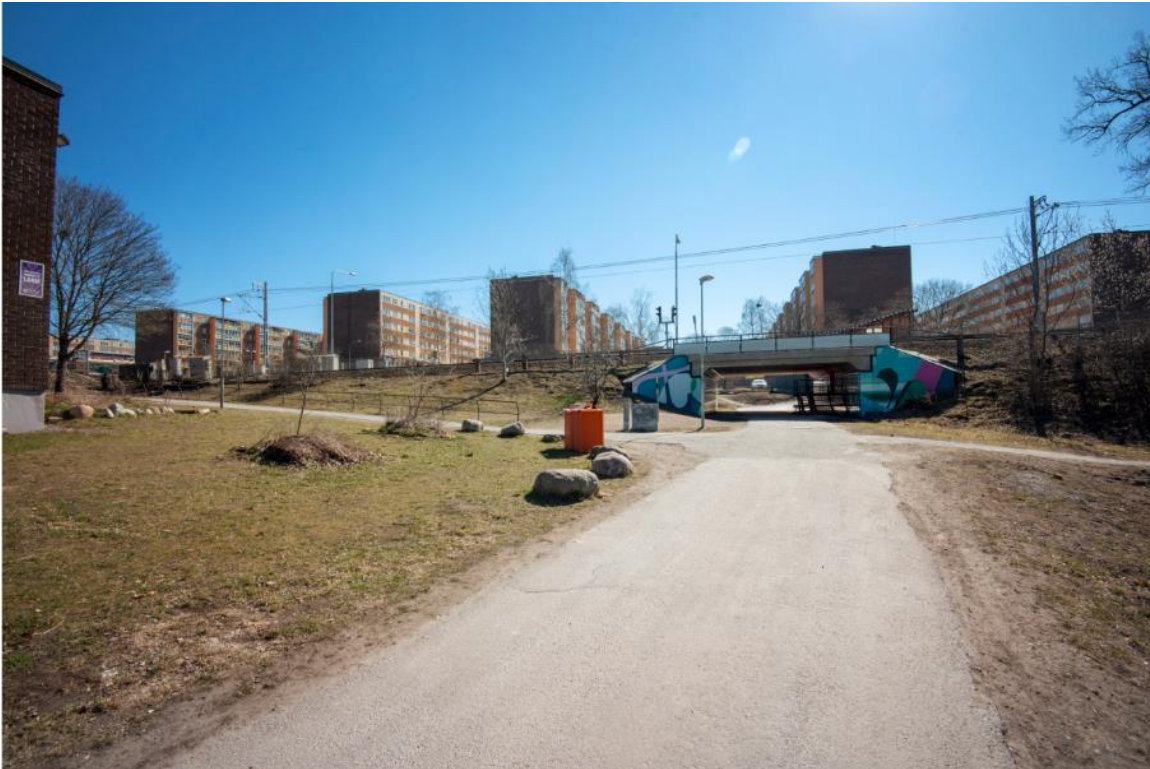
Gång- och cykeltunneln i planområdets västra del kopplar samman områdena norr och söder om Saltsjöbanan. Vy från norr. Foto av Sweco.
