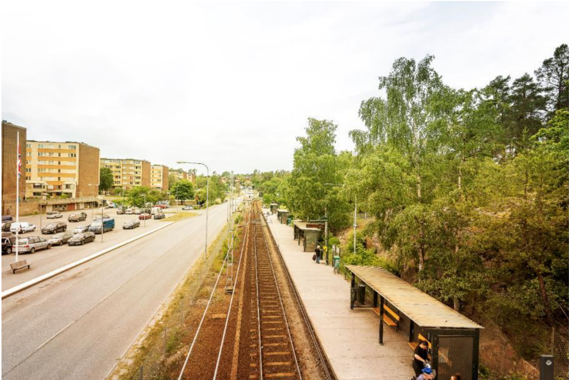
Dagens spårområde består av ett enkelspår med plattform på norra sidan. Vy från gångbron i öster. Foto av Sweco.
