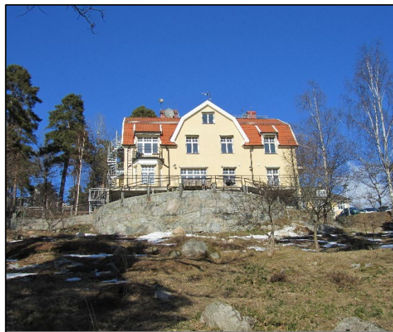
Villan sett från Vikingavägen/Pålnäsvägen.
