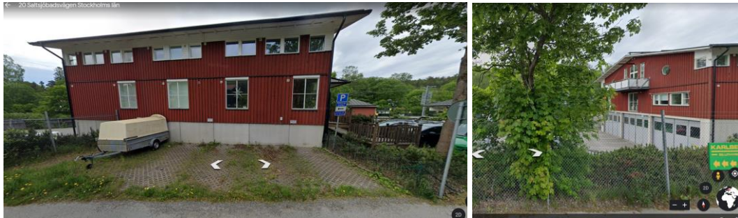
Bilderna visar befintlig kontorsbyggnad på Saltjöbadsvägen 20. Bilden till vänster visar fasad mot Saltjöbadsvägen och bilden till höger visar byggnaden med suterrängvåning mot söder. Utdrag från hitta.se april 2020.
