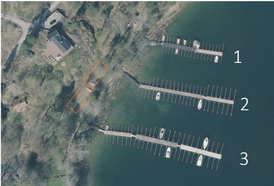
Ortofoto från 2018 med brygga 1, 2 och 3 markerade. Orange markering visar det område som bedöms ha så höga halter av föroreningar att nyttan av en sanering väger tyngre än natur- och kulturvärden samt strandskydd.
