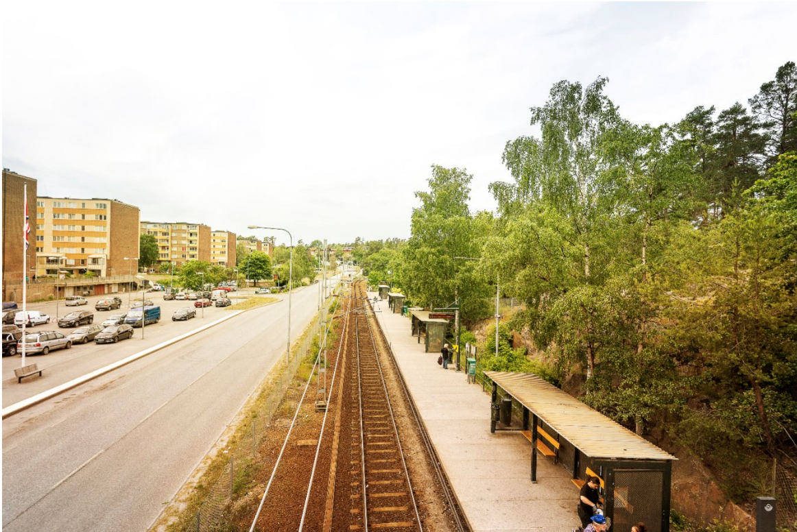
Dagens spårområde består av ett enkelspår med plattform på norra sidan. Vy från gångbron i öster. Foto av Sweco.
