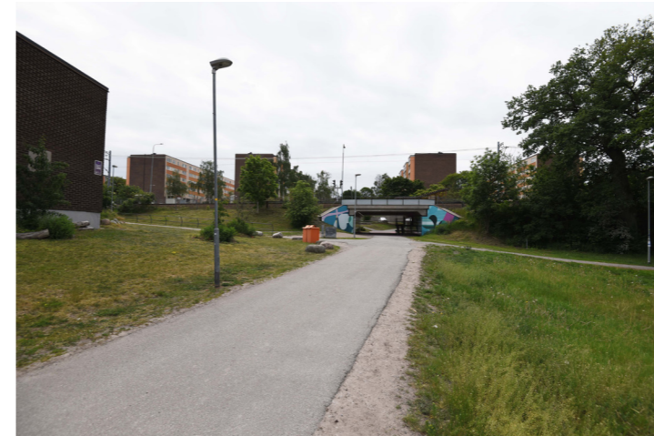
Bilden visar gång- och cykeltunneln under Saltsjöbanan som kopplar samman den norra sidan med Fisksätra centrum.
