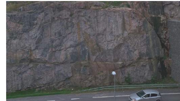
Referensbild. Bergskärning vid trafikplats Kvarnholmen.
