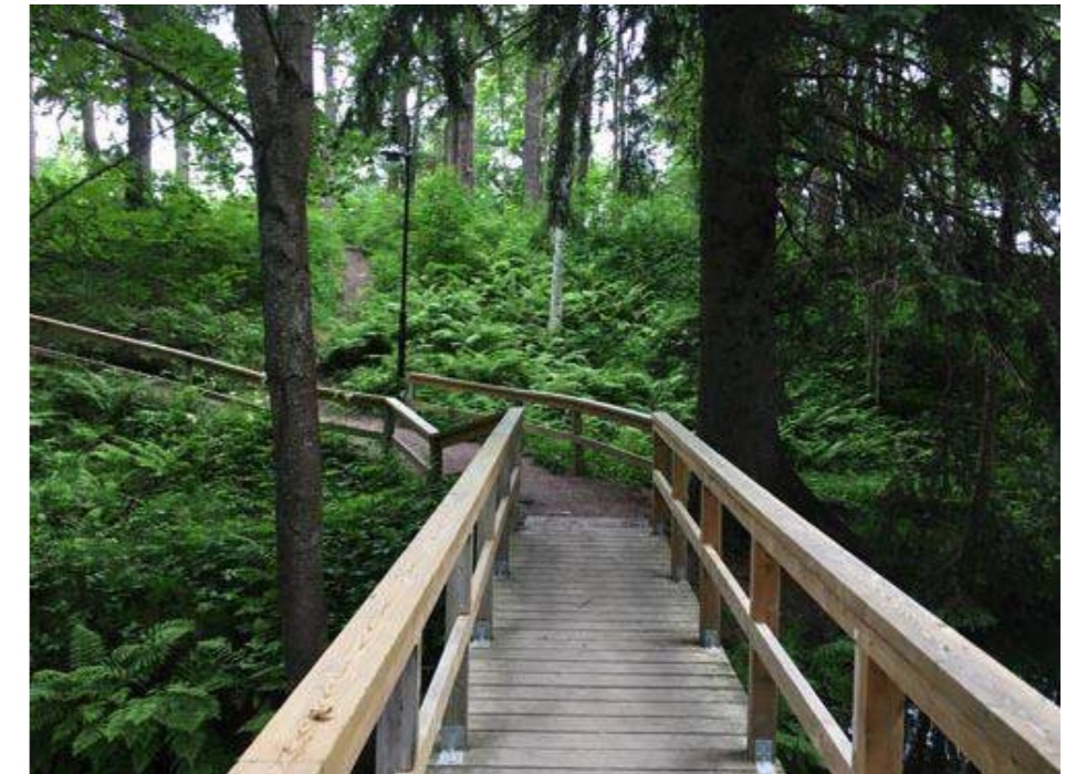
Träkonstruktion för att ta upp höjdskillnad
